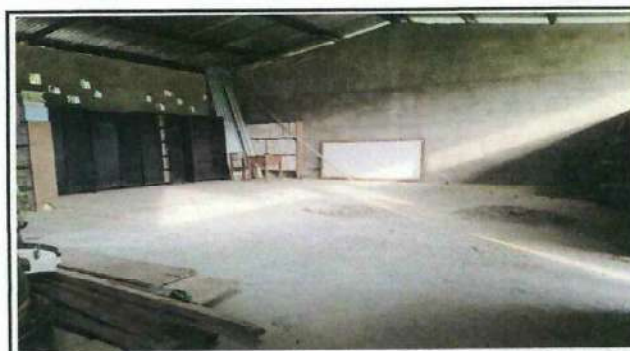
Foto 4: SUSTITUCIÓN DE PISO DE TORTA DE CONCRETO DE AULA POR PISO CERÁMICO
