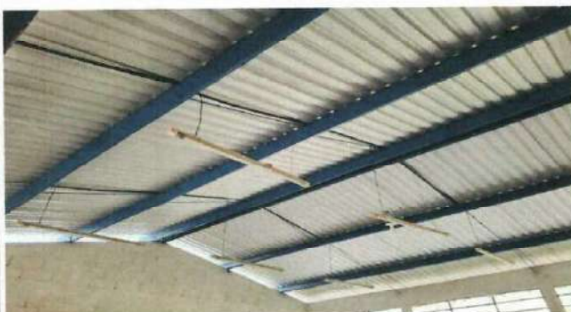
Foto 3: MEJORAMIENTO DE SISTEMA ELÉCTRICO
