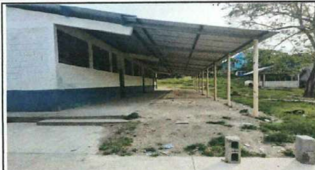
Foto 2: REPARACIÓN DE BANQUETA DE CORREDOR O REPARACIÓN DE PLANCHA DE CONCRETO.
