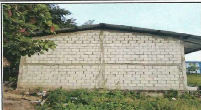
Foto1: APLICACIÓN DE REPELLO Y PINTURA DE EXTERIOR E INTERIOR
